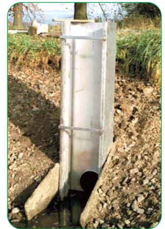
Abb. 7.5: Instandsetzung: Einbau eines modernen Edelstahlständers
